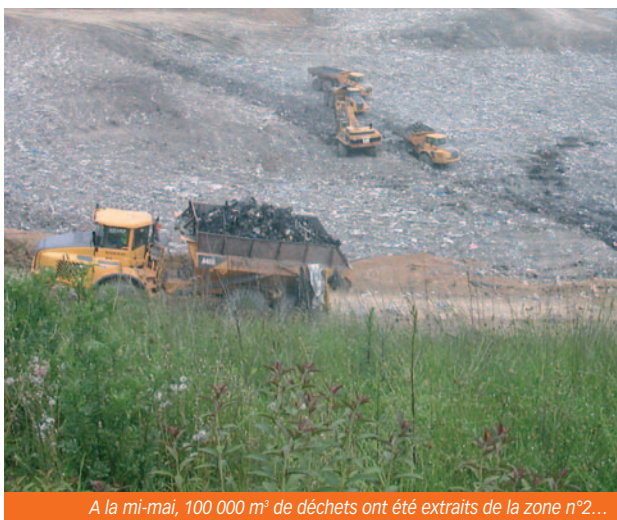
A la mi-mai, 100 000 m 3 de déchets ont été extraits de la zone n°2...
