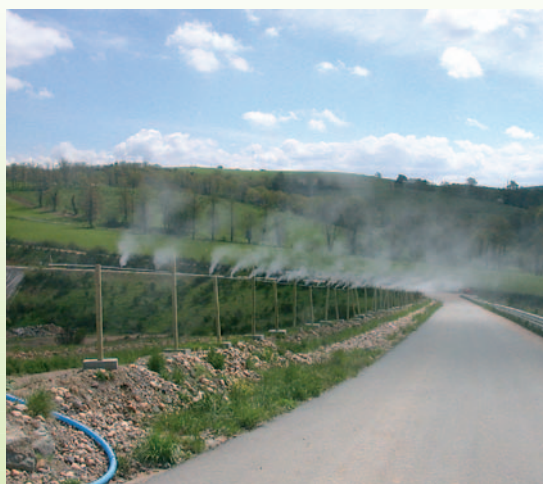
Rampe de pulvérisation sur le site
