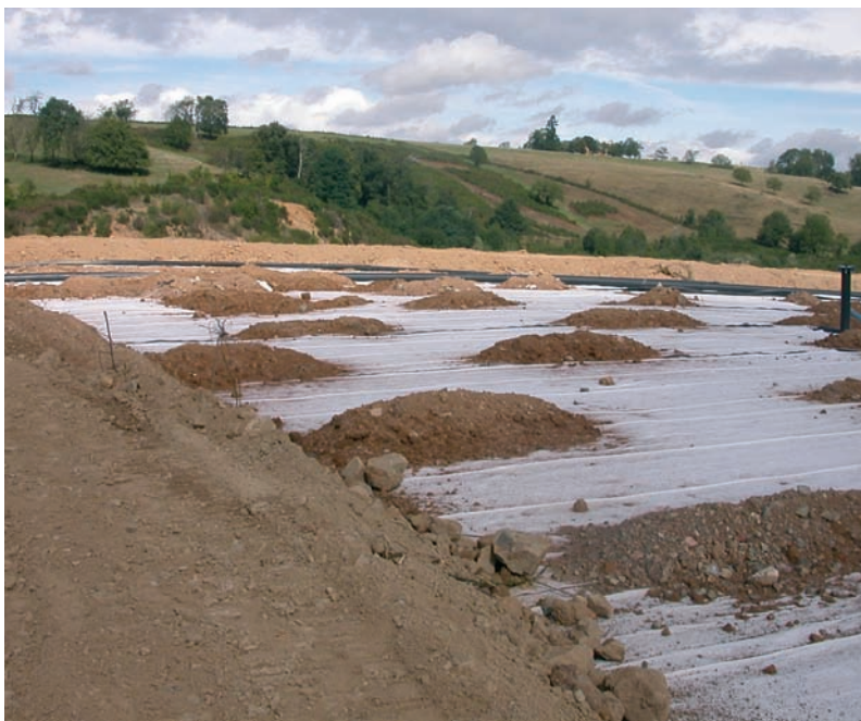
Membranes et terre recouvrent désormais la zone n°1
