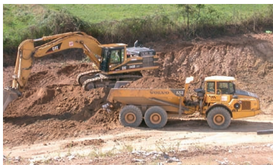
Chargement des matériaux pour le décaissement de la piste coté nord ouest du site
